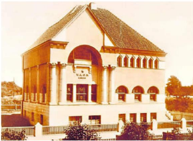
Logen-Neubau: Das Gebäude an der Hindenburgstraße im Jahr 1927.
